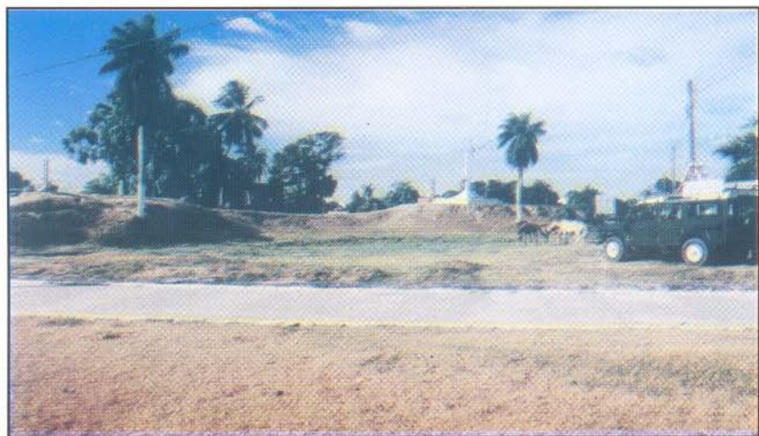
Ruínas do Arraial Novo do Bom Jesus. Observa-se uma cortina e dois bastiões com seus ângulos reentrantes e salientes. Foto Andreclck Fontes.
