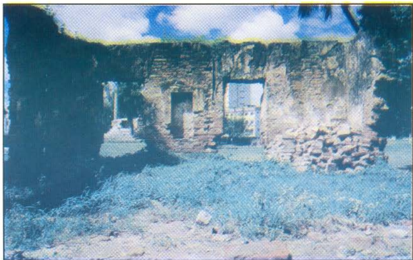
Arraial Novo do Bom Jesus. Ruínas de uma residência do século XIX construída sobre um bastião do Forte. Foto Doris Walmsley.
